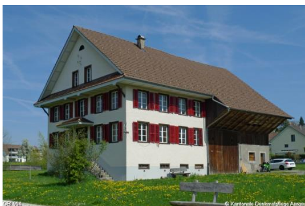
Gerberhaus (Quelle: Online-Inventar der Kantonalen Denkmalpflege Aargau)
