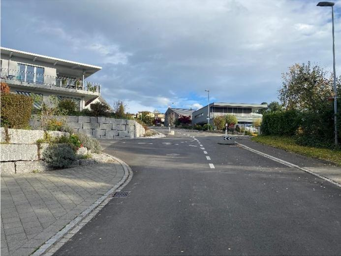
Die Sanierung der Augenweidstrasse wurde im Jahr 2022 abgeschlossen. Für die Sanierung wurde am 27.9.2020 ein Kredit von CHF 2'784'000 gesprochen. Dafür wurden die Wasser-, Abwasser- und Elektraleitungen erneuert und mit einem neuen Deckbelag überzogen.
